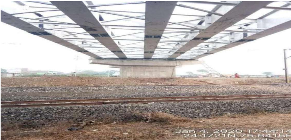
36 MTR. & 24 MTR.SPAN IN LIEU OF LC-32, CHAUMEHLA, WCR KOTA DIVISION
