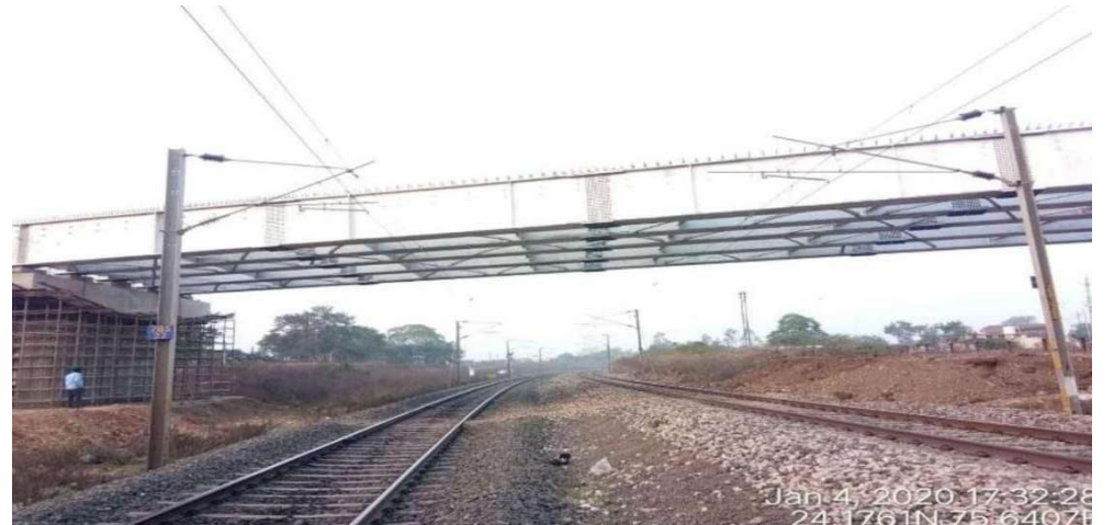
36 MTR. & 24 MTR.SPAN IN LIEU OF LC-32, CHAUMEHLA, WCR KOTA DIVISION
